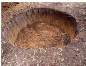
Der Brunnenbau beginnt
